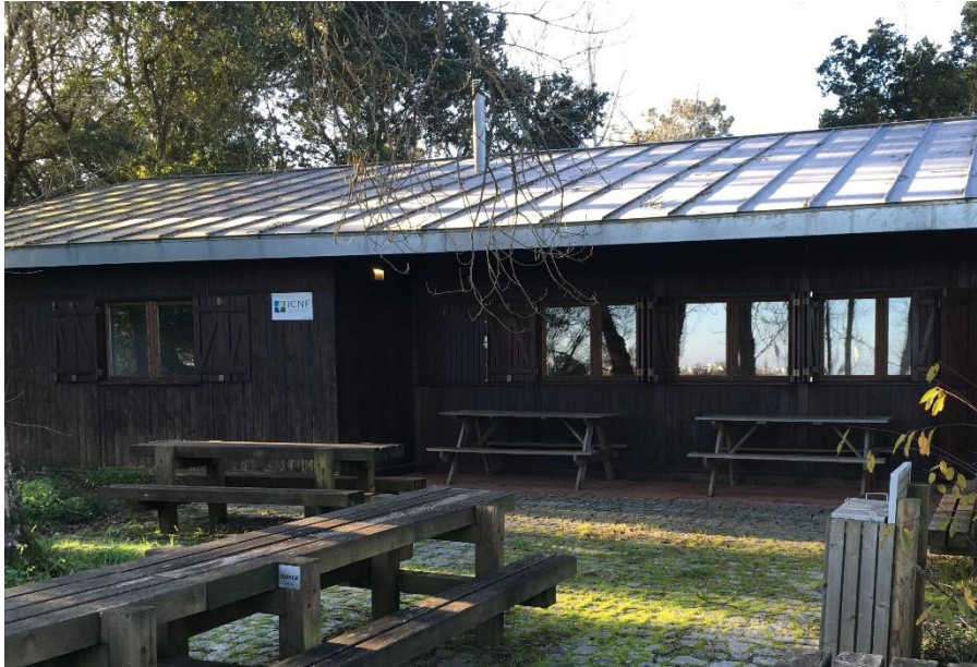
Figura 9. Centro de Acolhimento
