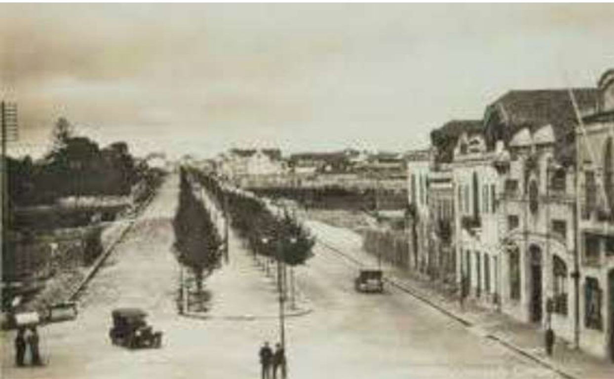
Vista da Avenida (final dos anos 20) em "Programa Preliminar - Av. Lourenço Peixinho"
