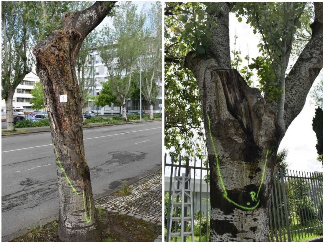
Figura 5.1 – Esquerda: árv. n° 1 com grave podridão a prolongado pelo tronco. Direita: Árv. n° 4 com cavidade e local (.R) da medição com resistógrafo.
