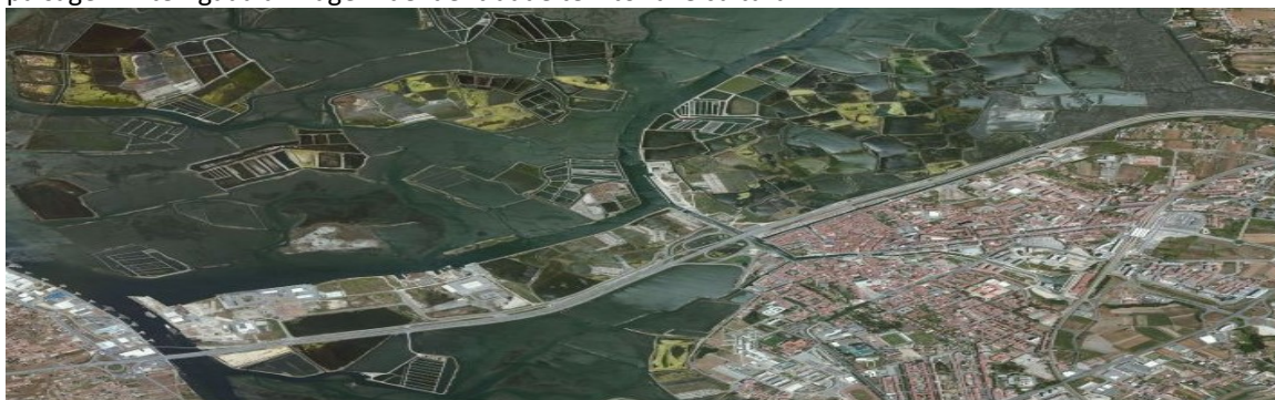
Figura 17 – Vista aérea do Salgado de Aveiro (Fonte: http://www.bing.com/maps/ )
