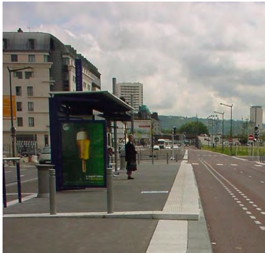
Rouen: paragem de um sistema Optiguide e que garante a acessibilidade para todos
